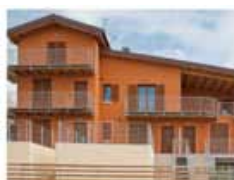
Casa Solare Santa Maria Nuova/ 2010/Ancona/Marche Energy Resources
