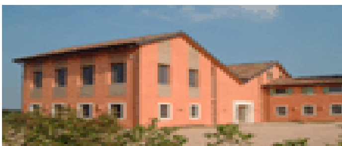
Ristrutturazione e riqualificazione energetica della Corte Il Torrazzo, Volon di Zevio/Verona/2005, materiali ecocompatibili.
