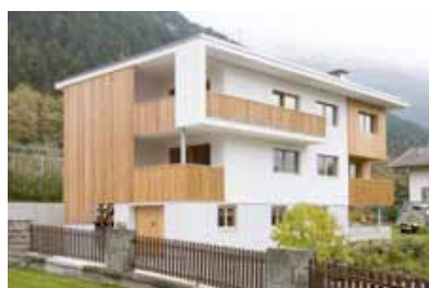
Edificio plurifamiliare a Oris, Bolzano/Trentino Alto Adige/2011
