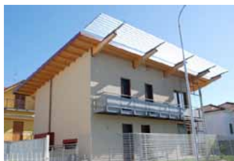
Brembate Sopra. Casa del Sole. Struttura mista calcestruzzo-S/R (Vanoncini) Bergamo/Lombardia/2009
